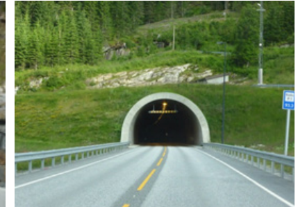
Portalområder som ligger lettere i landskapet kan utføres med portalbrem med helning 1:2/1:1,5 slik at terrenget føres ned fra overkant forskjæring langs portalene.
