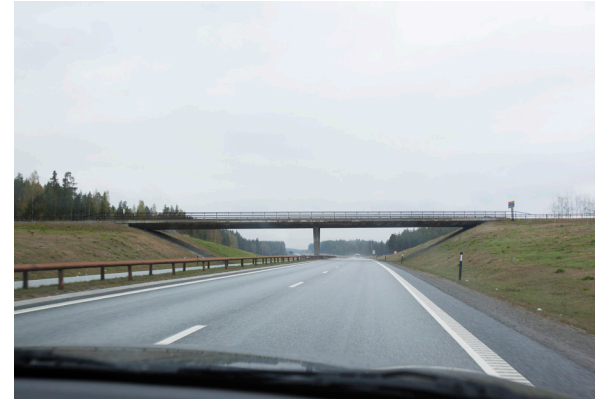
Eksempel på enkel utformet overgangsbro. Terrenget flyter igjennom. Ved ønske om kortere overgangsbroer vil det være ekstra viktig å formgi terrenget under broene over et lengre strekk, slik at ikke disse punktene blir visuelle «innsnevringar» langs linja. Bildet er tatt langs E6 mellom Gardermoen og Hamar. Foto: Marius Fiskevold
