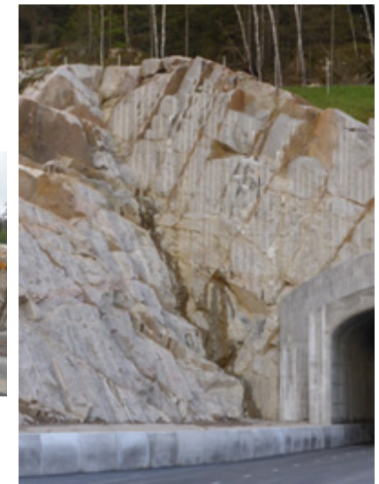
Portalområder som ligger lettere i landskapet kan utføres med portalbrem med helning 1:2/1:1,5 slik at terrenget føres ned fra overkant forskjæring langs portalene.
