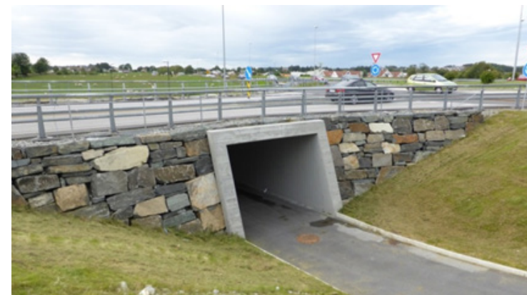
En undergang for myke trafikanter under en tungt trafikkert vei. Natursteinsmuren og terrenget rundt skaper en god løsning for undergangens inn- og utgang. Foto: Henrik Undeland
